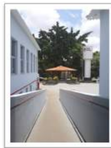
Rampa de Acesso
