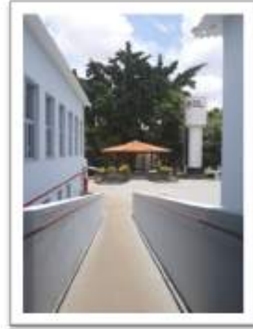
Rampa de Acesso
