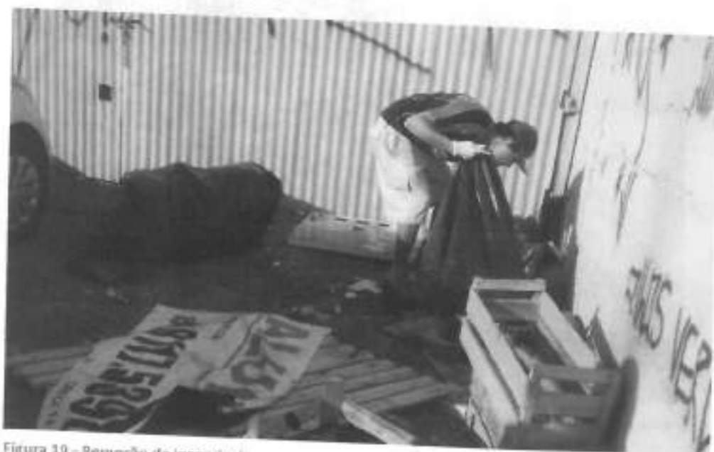
Figura 19 - Remoção de inservíveis
