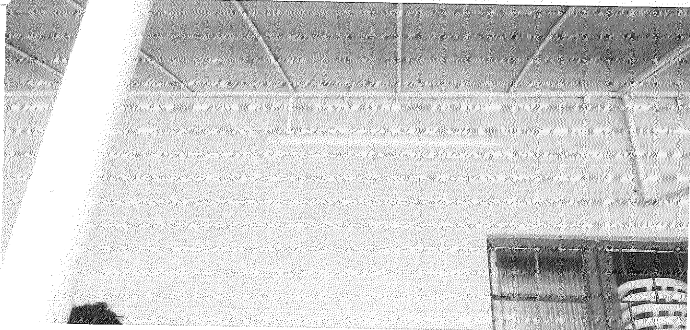
Instalação de luzes externa.
