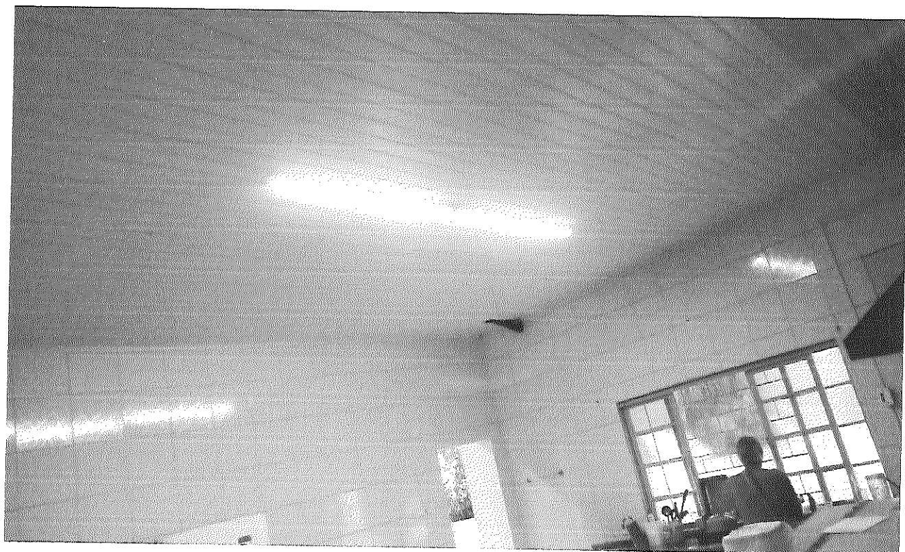
Revisão/ Renovação da fiação e colocação das lâmpadas de LED cozinha.
