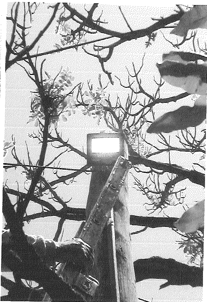
Confecção de fiação elétrica e instalação de sistema de iluminação com 02 refletores de led com fotocélula.
