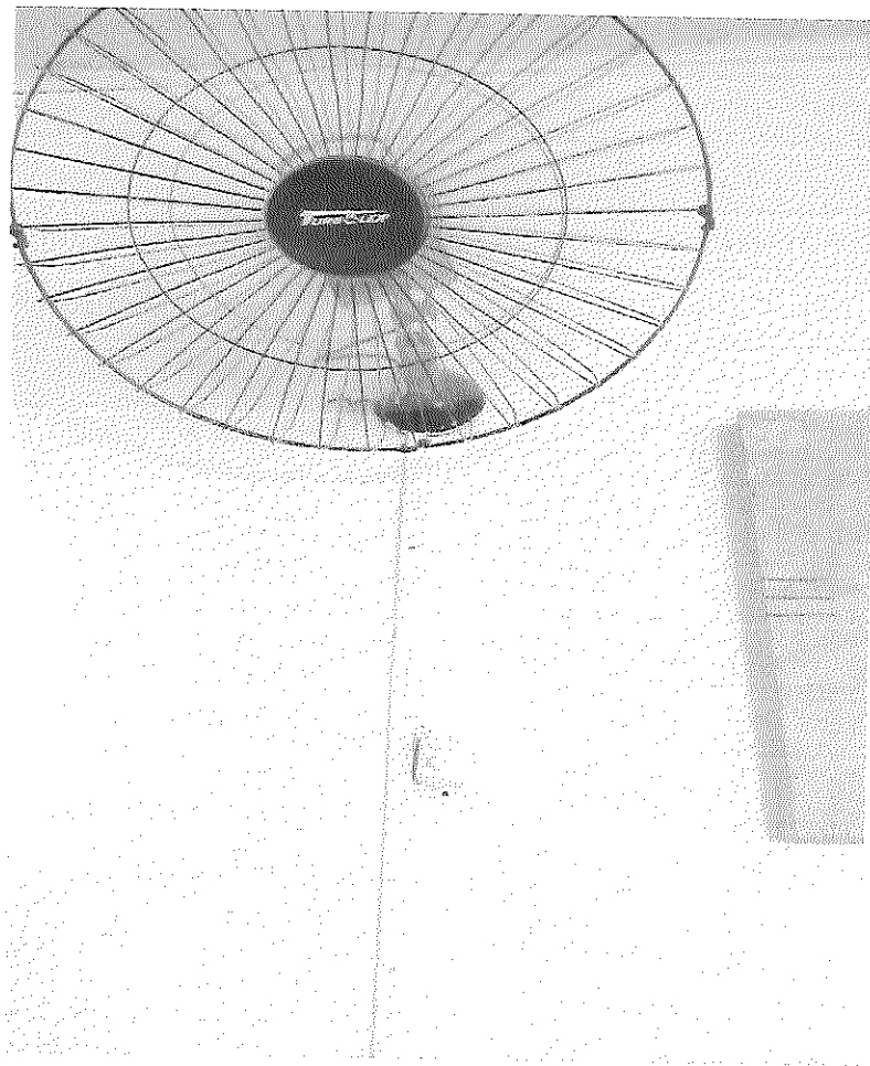
Instalação de ventilador fios, interruptores.
