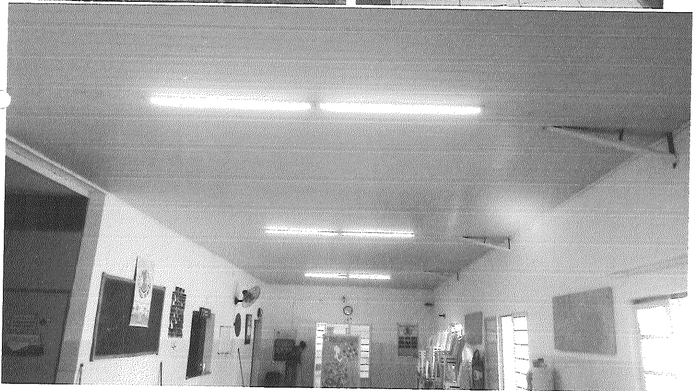
Revisão elétrica, ampliação de fiação e instalação de lampadas de led nas salas, dispensa e refeitório.
